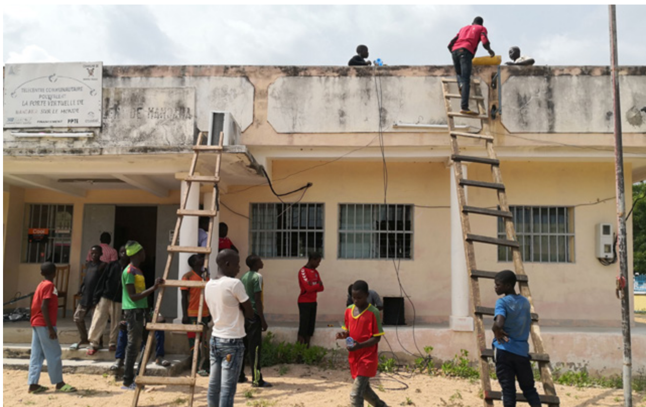
INSTALLATION D'UN RÉSEAU WI-FI À BIBEMI.
